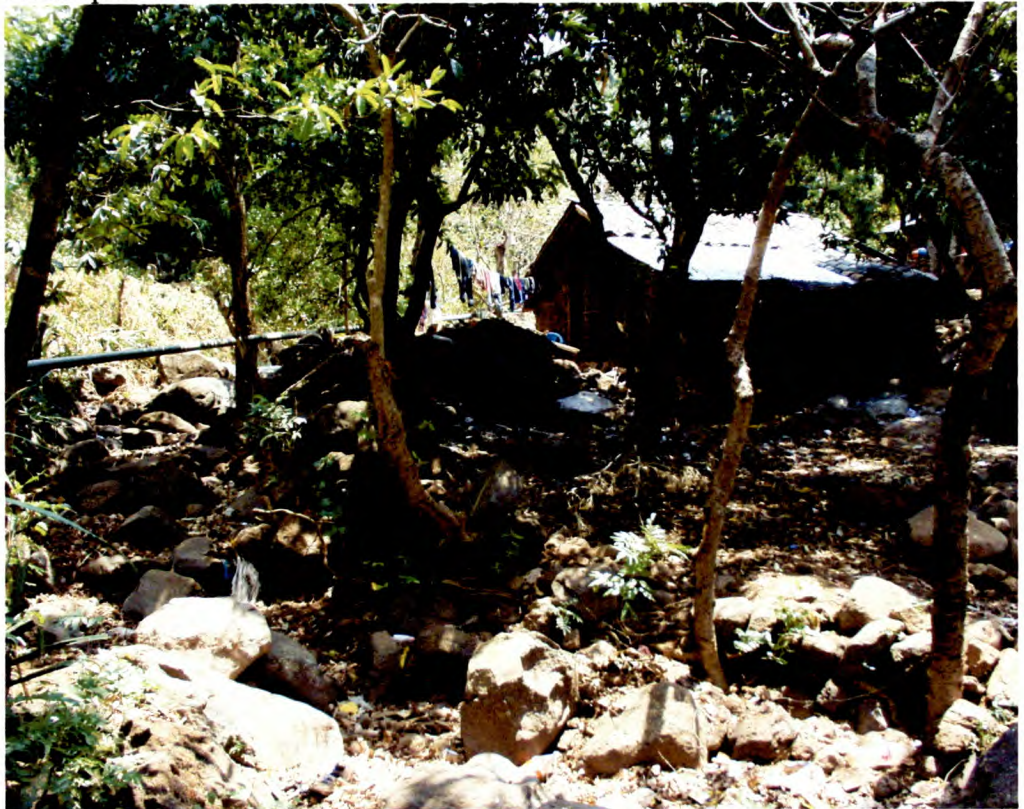
Foto No. 14: Caserío El Carasimo: la casa construída inapropriadamente sobre de la acumulación de bloques que rellenan al cauce. En este caso se trato de alto riesgo de la construcción puesto de que ésta puede ser destruída por flujos torrenciales.
